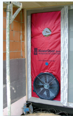
BlowerDoor Messung eines neu gebauten Einfamilienhauses
