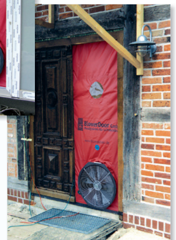
BlowerDoor Messung im Rahmen einer Fachwerksanierung
